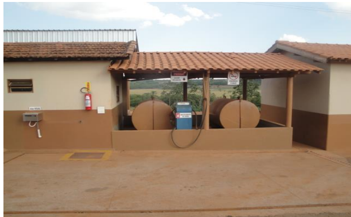
Foto 9: Local de Abastecimento a diesel.
