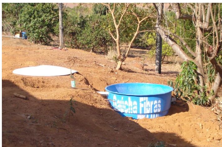
Foto 10: Caixa de Contenção – Água residuária de agroquímico.
